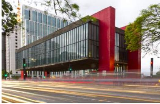
As paredes da fachada em concreto aparente foram pensadas e feitas em ângulos de 20° e com espelhos de vidros no ângulo de 60° para aproveitamento da iluminação natural e causando sensações ao observador de uma edificação sólida e robusta e ao mesmo tempo parte integrante da cidade.
