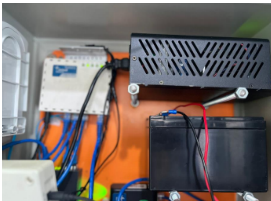
FIGURA 3 – Conversor de fibra óptica para rj45, com sistema de nobreak
