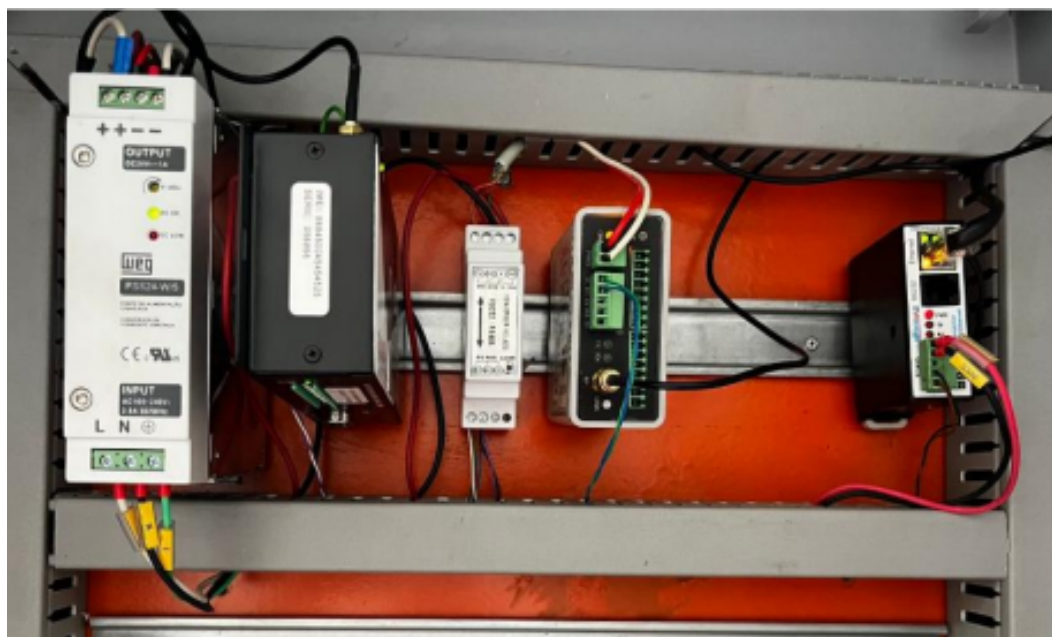
FIGURA 3 – Conversor de fibra óptica para rj45, com sistema de nobreak
