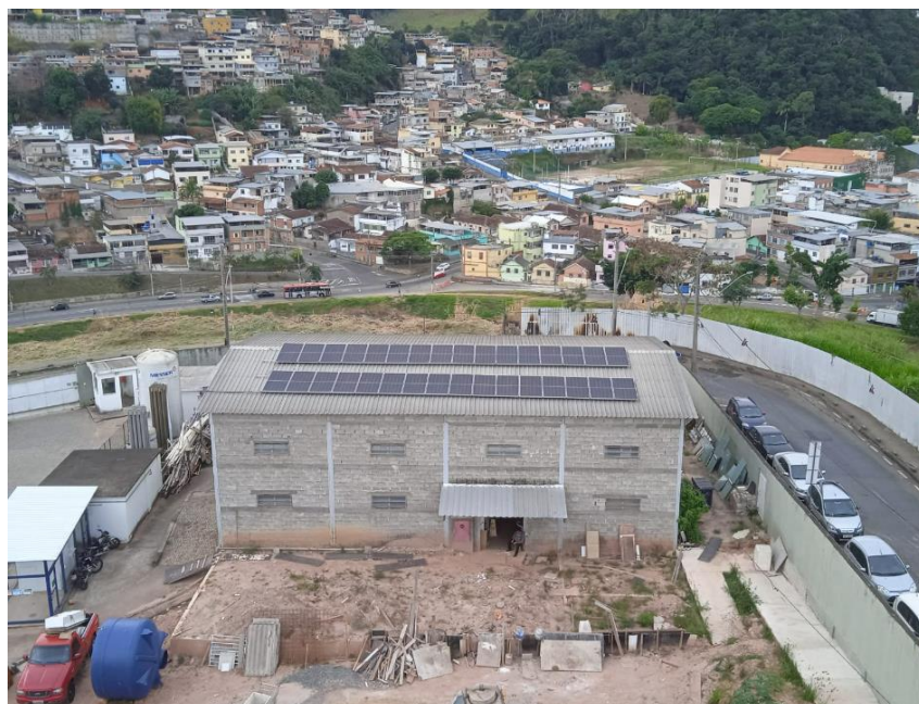
Figura 4 - Instalação das Placas Solares
