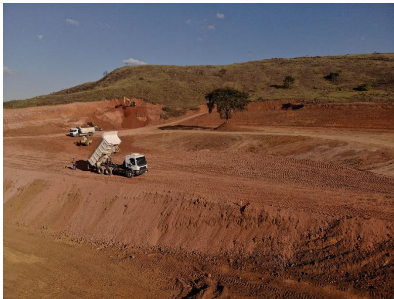
Figura 2: Inspeção de obra de Terraplanagem
