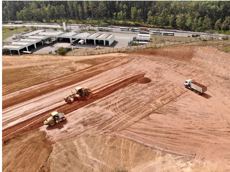
Figura 09: Acompanhamento de obra
