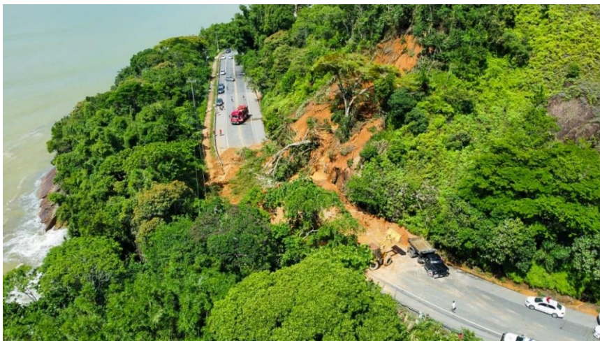
Figura 9: Deslizamento decorrente das chuvas na SP-55 em Ubatuba, SP.
