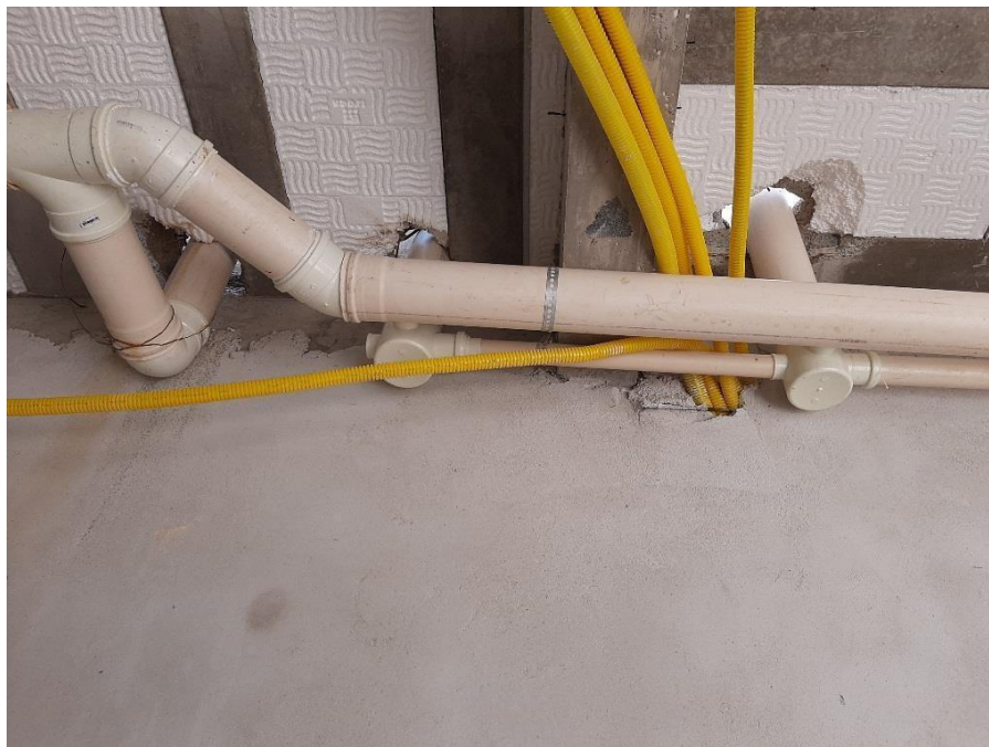
Figura 22: Furo na viga e laje para a passagem dos canos para instalação hidráulica.
