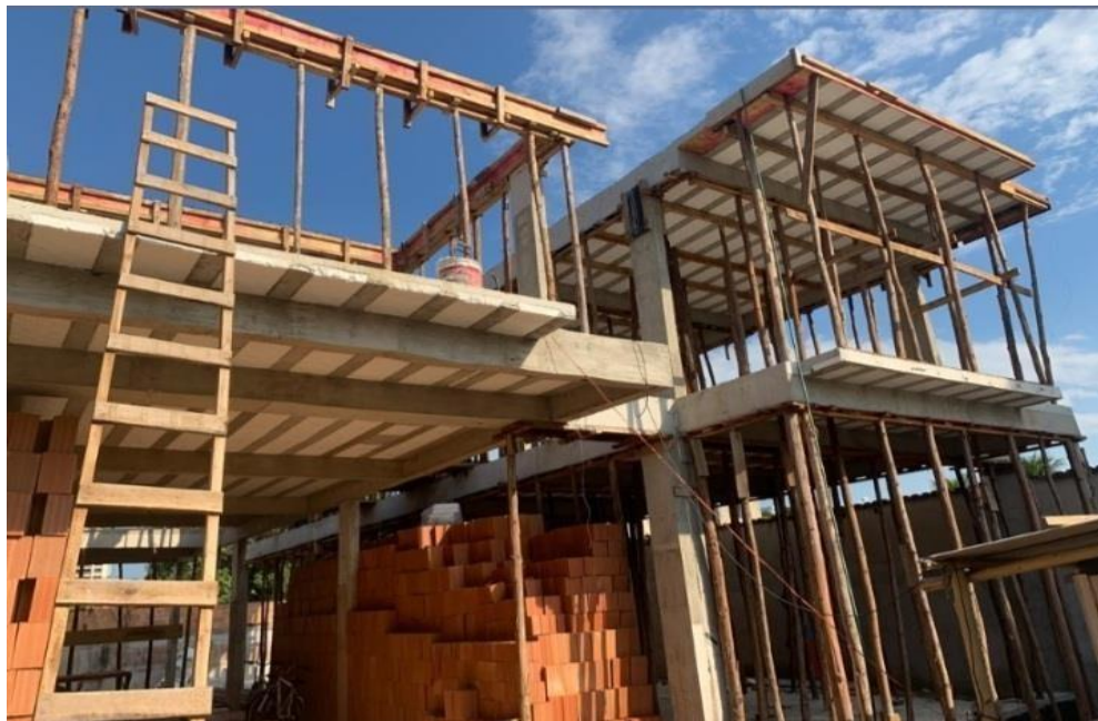
Figura 15: Execução da estrutura das residências
