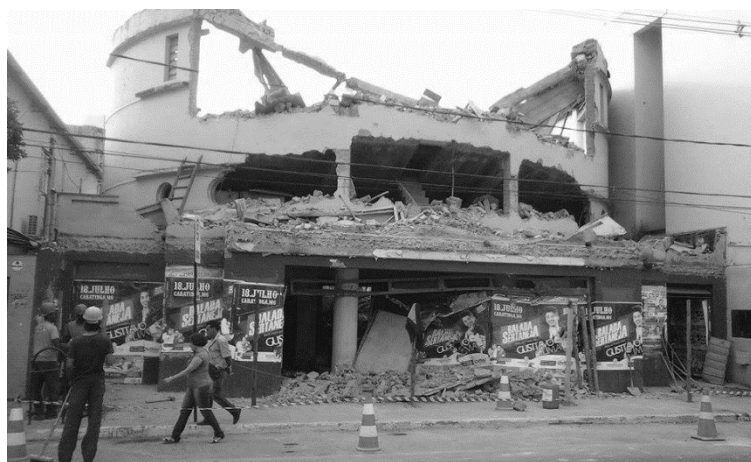
Figura 2 – Cine Brasil após o processo de demolição parcial
