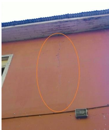
Figura 1 – Fissuração.
