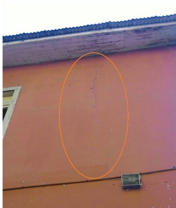
Figura 1 – Fissuração.
