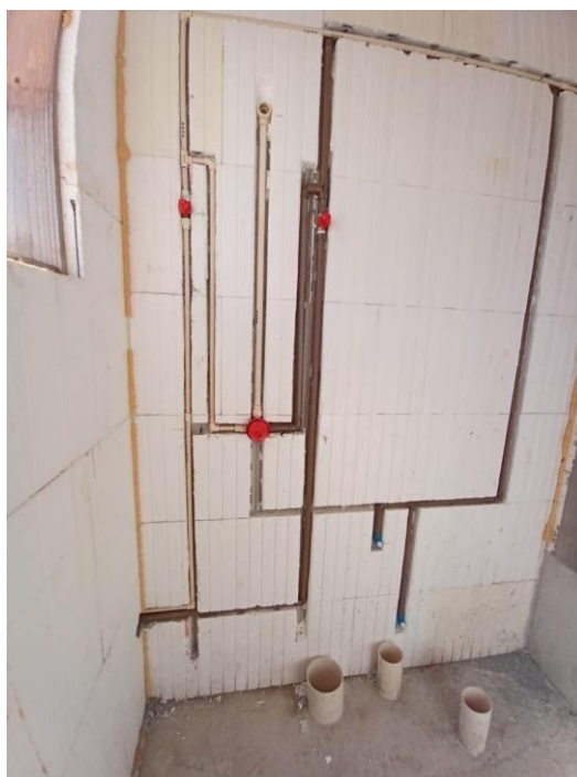
Figura 16. Abertura para passagem de tubulação
