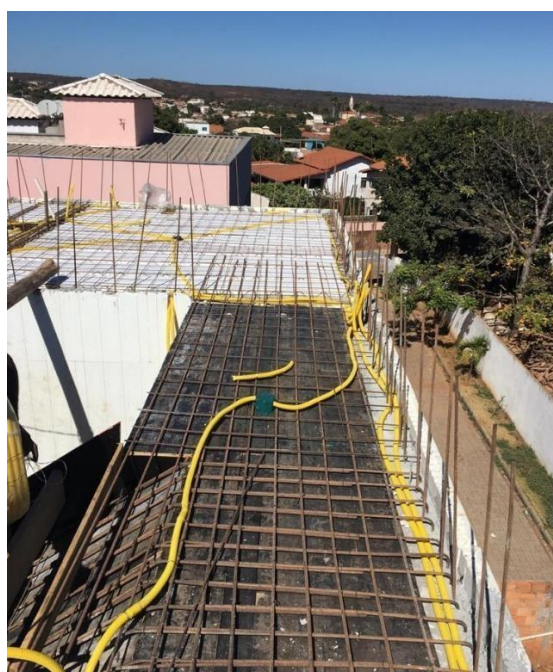
Figura 15. Ancoragem da laje
