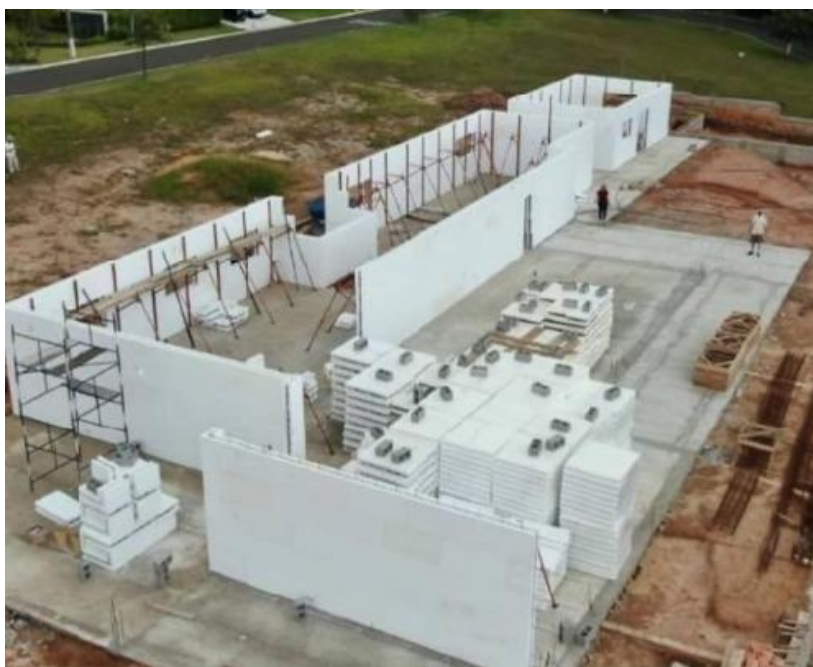
Figura 7. Sistema construtivo enxuto com pouco resíduos e pouco materiais estocados
