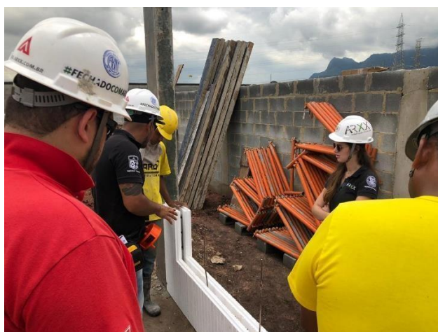
Figura 11. Colocação das barras de aço
