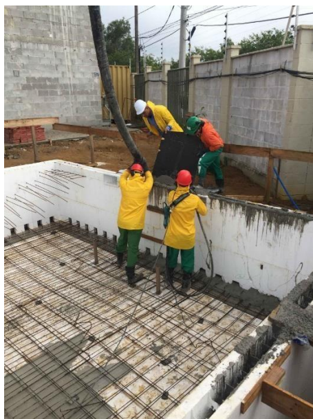
Figura 13. Concretagem dos blocos
