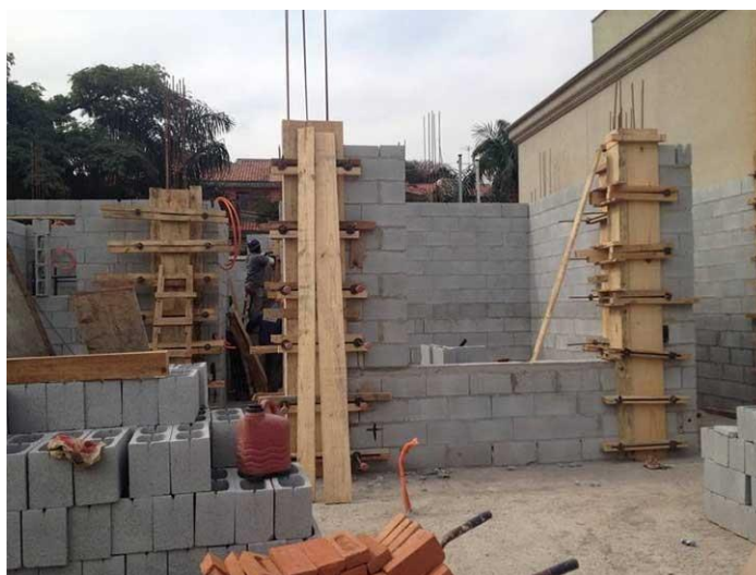
Figura 4. Blocos e formas em alvenaria de vedação
