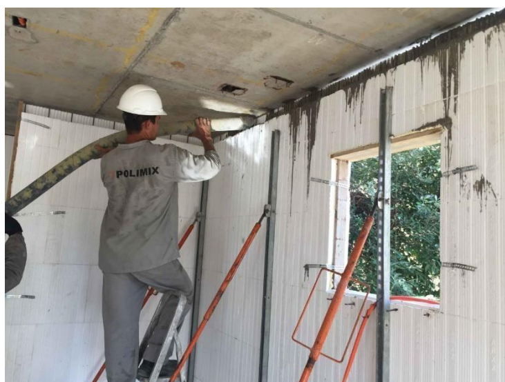
Figura 14. Concretagem dos blocos
