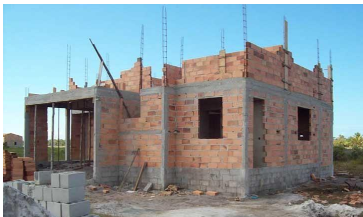
Figura 3. Sistema construtivo convencional
