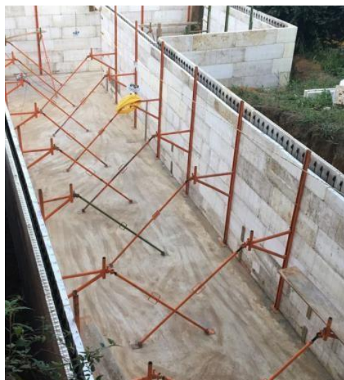
Figura 12. Escoramento metálico
