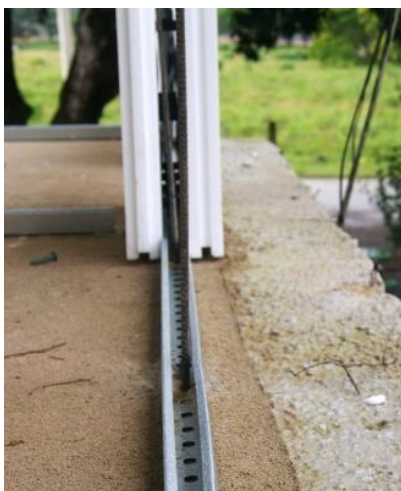
Figura 10. Ancoragem da 1ª fiada dos blocos VA40
